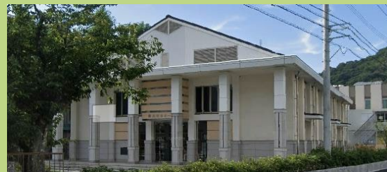
南加記念ホール外観（南側から）
