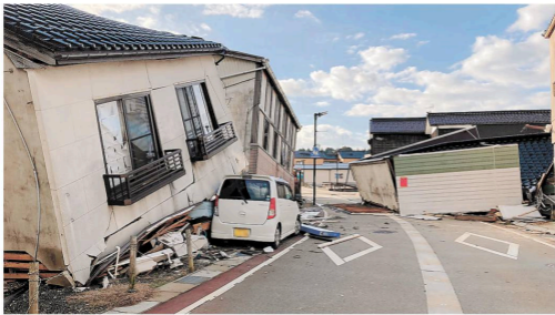
能登半島地震で1階部分がつぶれた2階建て住宅や事業所など＝1月5日、石川県穴水町（森特定教授撮影、車のナンバープレートを画像加工しています）
