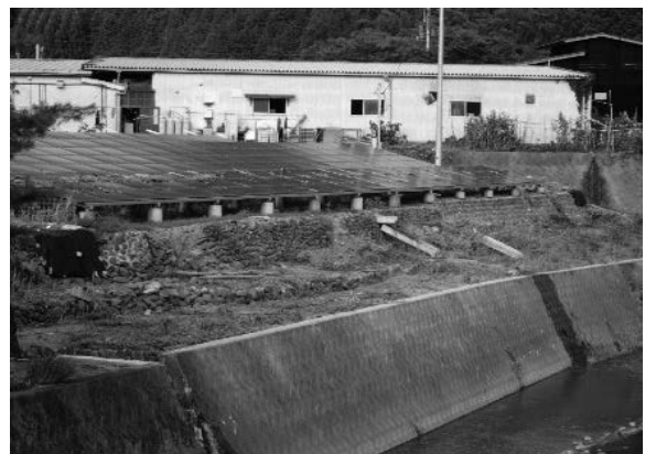
写真 2. 1. 4-45 ②鏡川橋下流左岸側
