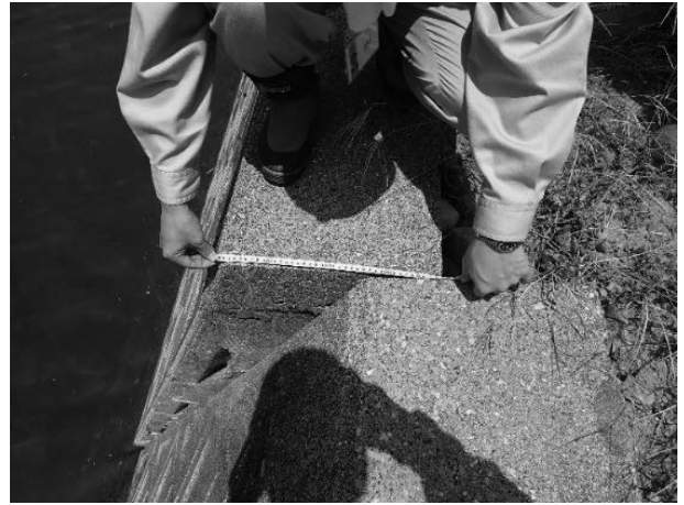
写真 2. 1. 4-33 ④楠橋右岸コンクリートブロック
