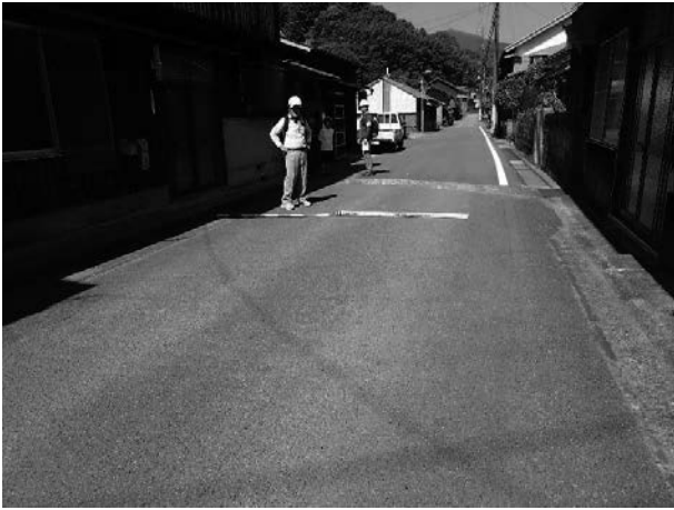
写真 2. 1. 4-62 ③商店前の浸水範囲（奥が浸水）
