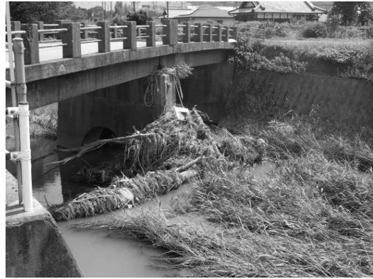
写真 2.1.4-16 ④中番新橋上流側
