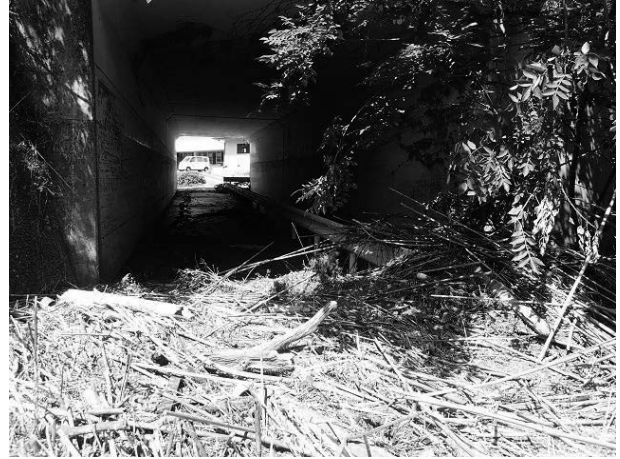
写真 2. 1. 4-63 ④ボックスカルバート
