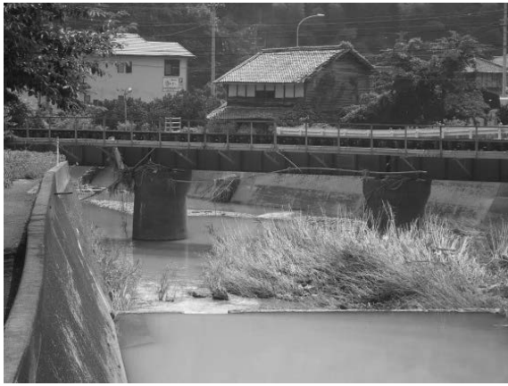
写真 2. 1. 4-19 ④竹城下第1踏切南の鉄橋
