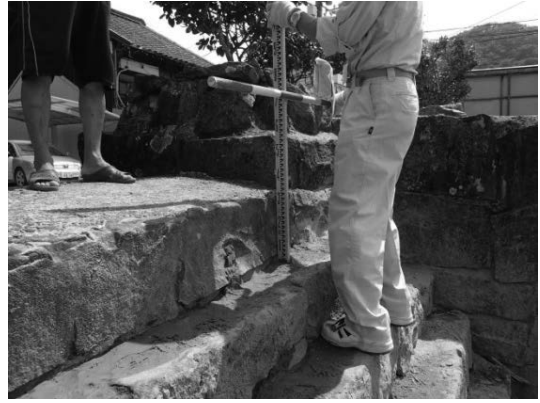
写真 2. 1. 4-25 立間川の護岸階段
