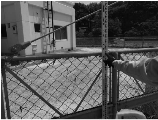
写真 2. 1. 4-7 ③吉田排水機場
