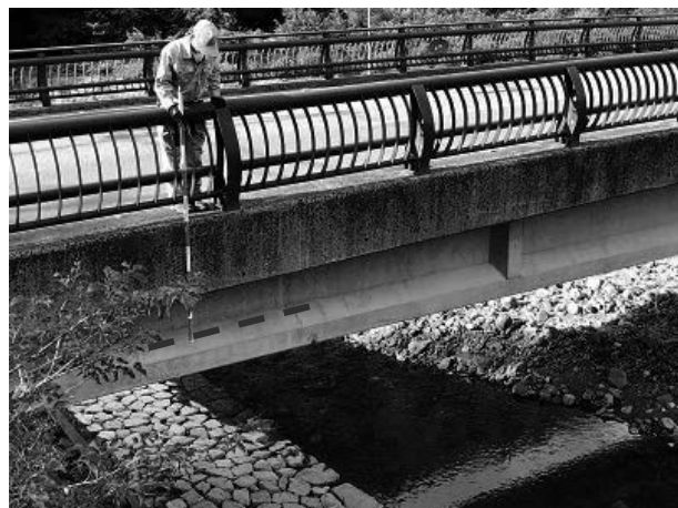
写真 2.1.3-4 ⑤河辺橋における水位痕跡
