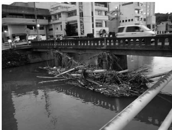
写真2.1.4-38 ⑤はまだ橋
