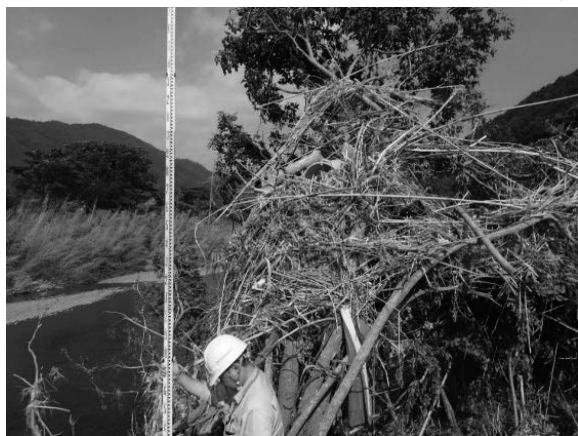
写真 2.1.4-54 ②合流部の堤防先端部
