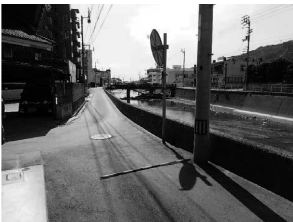
写真 2.1.4-39 ⑥千丈川左岸から下流向き
