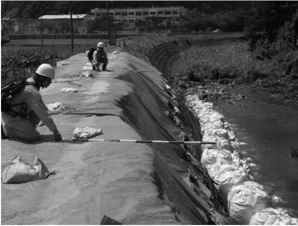
写真 2. 1. 4-30 ①中央橋下流右岸側
