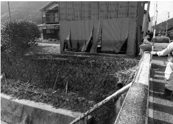
写真 2. 1. 4-44 ①鏡川橋上流左岸側
