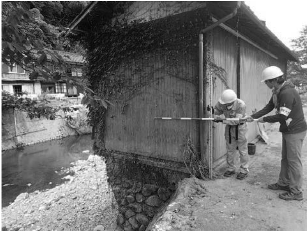
写真 2. 1. 4-69 ②中川原橋右岸上流
