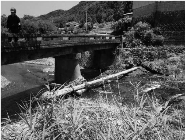
写真 2. 1. 4-32 ③上屋敷橋上流左岸側
