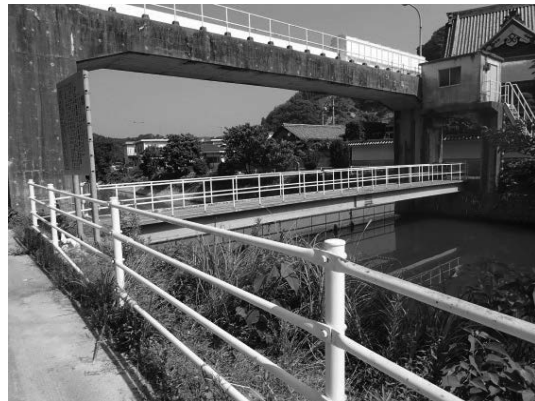
写真 2.1.4-2 ②河内川第一水門
