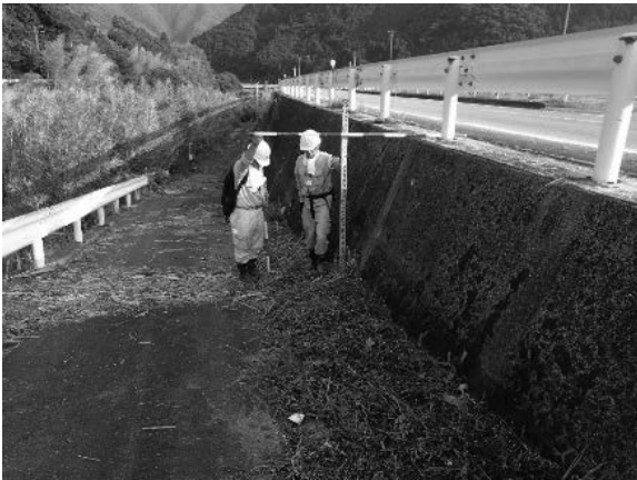
写真 2. 1. 4-48 ⑤新鏡川橋下流右岸
