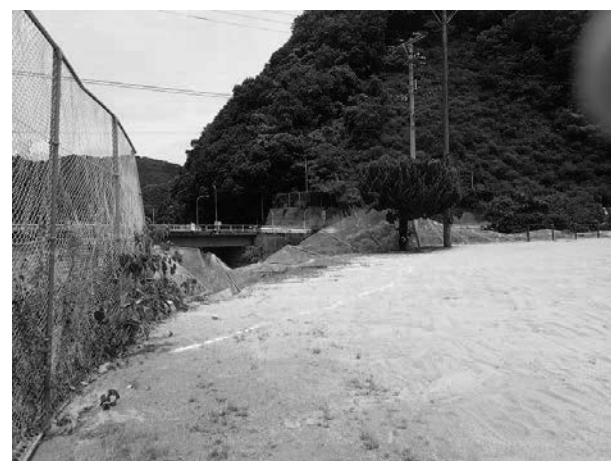
写真 2.1.3-6 ⑦肱川中学校グラウンド
