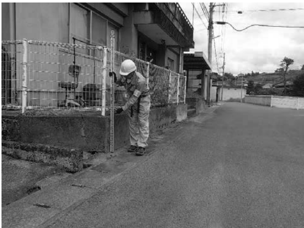
写真 2. 1. 4-71 中川原橋左岸上流
