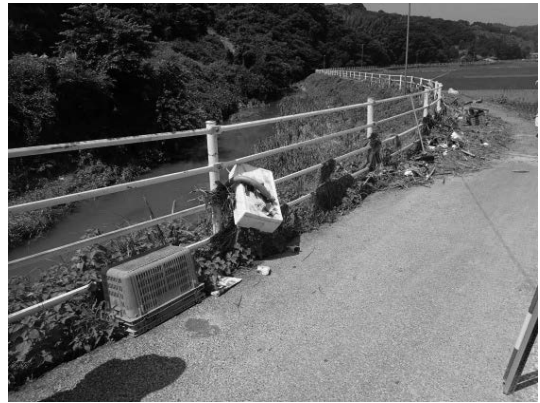
写真 2. 1. 4-8 ④仕出橋上流左岸フェンス
