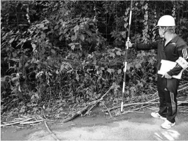
写真 2. 1. 4-66 ③山際の浸水痕跡
