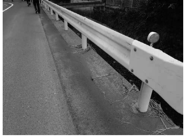
写真 2.1.4-42 ⑩支流のガードレール支柱痕跡
