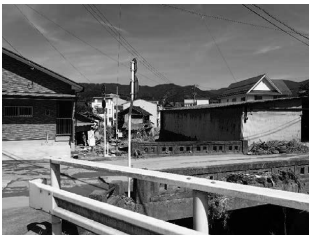
写真 2.1.2-4 ⑦愛宕橋上流から
