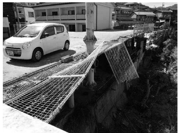
写真 2.1.2-5 ⑨野村大橋下流左岸
