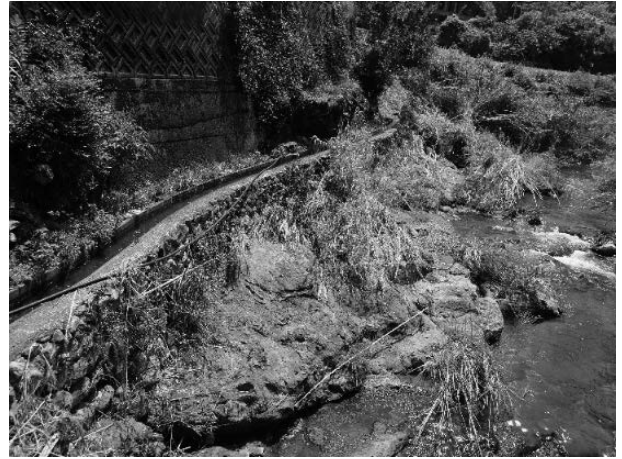
写真 2. 1. 4-31 ②上屋敷橋上流右岸側
